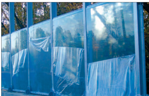
Монтаж оргстекла на конструкцию акустического экрана
